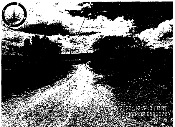
Foto 06: Ponto Final - Trecho 02 - Oitis Coordenadas: 24M 308437 9562072
