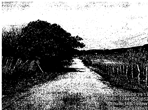
Foto 14: Passagem Molhada Coordenadas: 24M 311744 9573852
