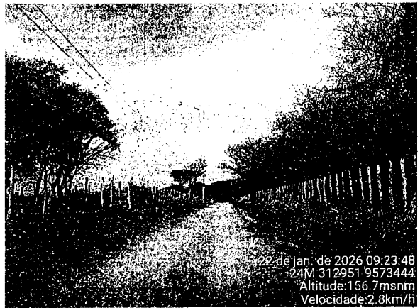
Foto 12: Trecho Cacimbas/Morrinhos Coordenadas: 24M 312951 9573444
