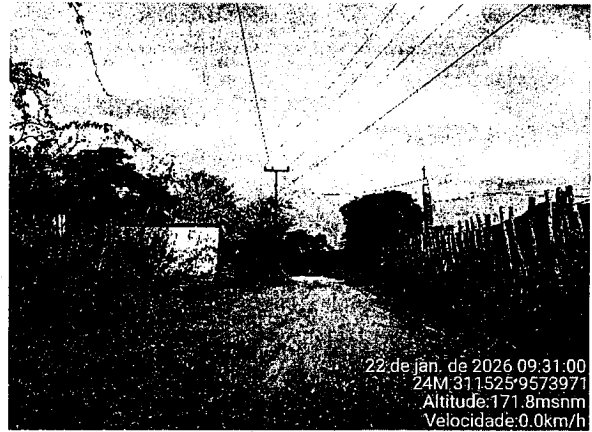
Foto 08: Trecho Cacimbas/Morrinhos Coordenadas: 24M 311525 9573971
