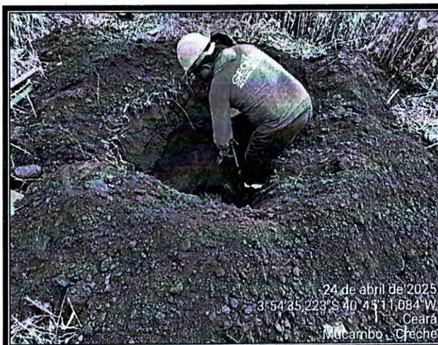
Foto 3 – Colocação de água na vala (0,3X0,3x0,30m) um dos procedimentos para fazer o teste de absorção do solo
