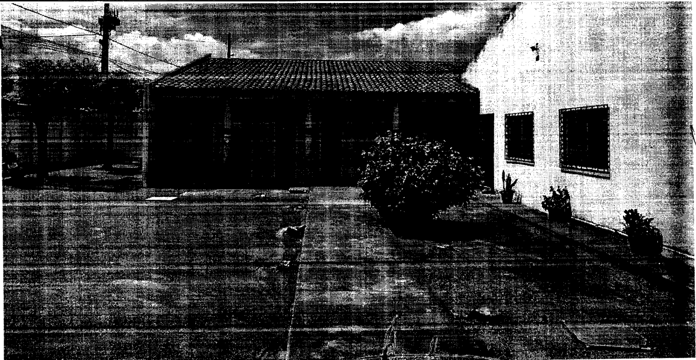
CALÇADA DE ACESSO AO PÁTIO
