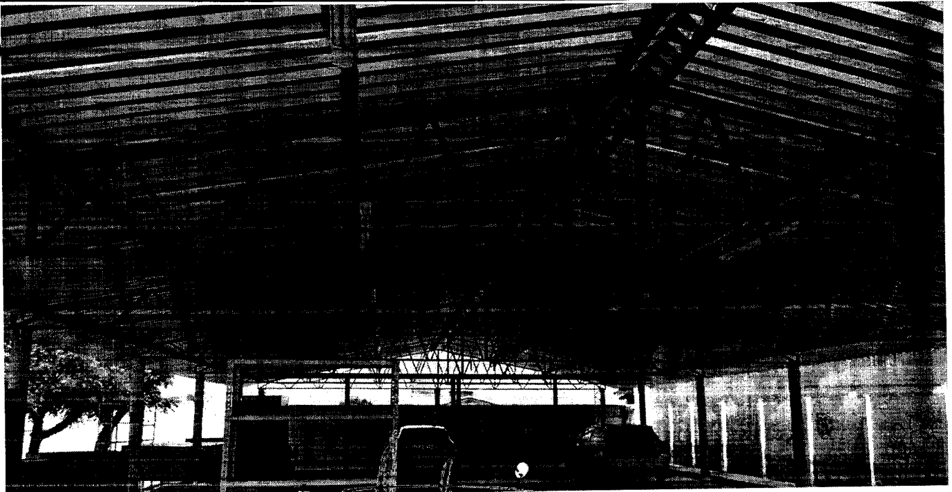
ESTRUTURA QUE SERÁ PINTADA DO PÁTIO
